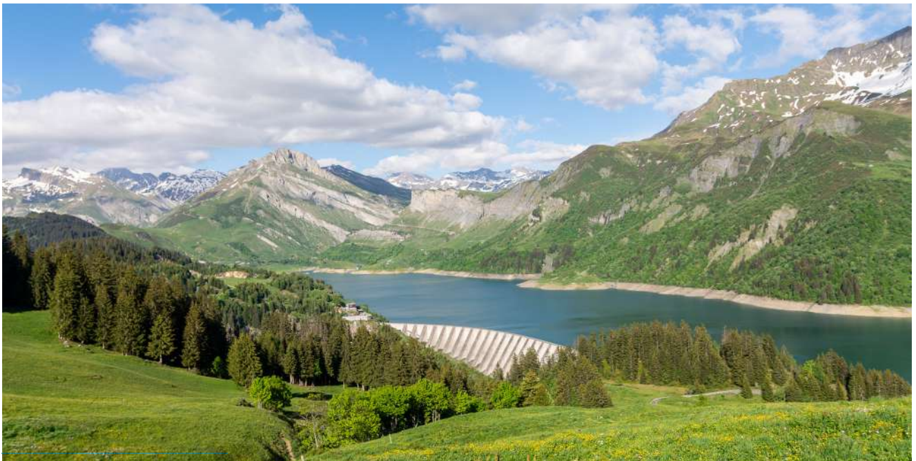
Barrage de Roselend. France P.
