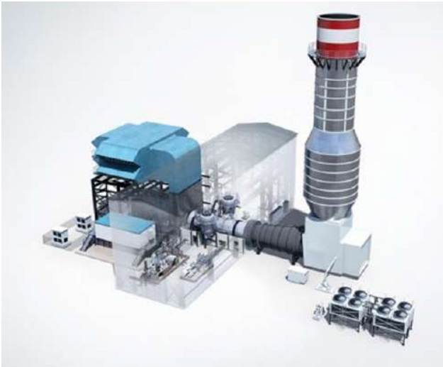
Fig 28. Illustration d'une centrale à turbine à gaz (modèle AE-94.2)
