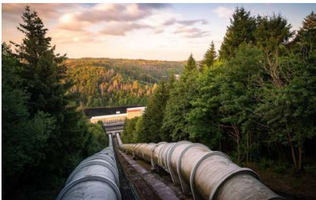
Conduites forcées d'une centrale hydroélectrique
